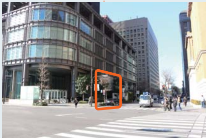
東京駅方面から
